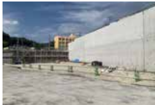
小部小学校前の工事
