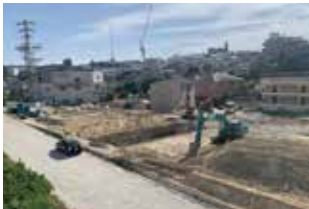
変電所北側工事
